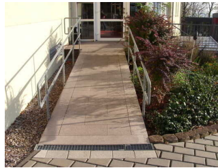
Hoteleingang Rezeption mit Rampe
