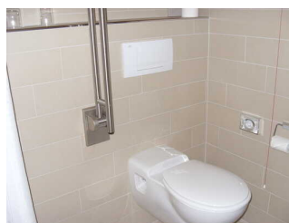
Badezimmer 112 Dusche und WC mit Haltegriffen
