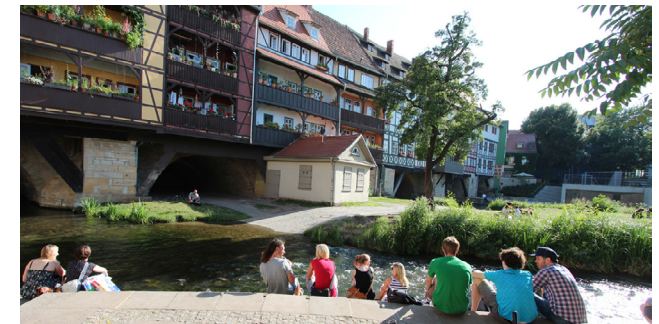
Krämerbrücke in Erfurt
